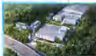
贵州德义汇川酒糟生物发酵饲料工厂
